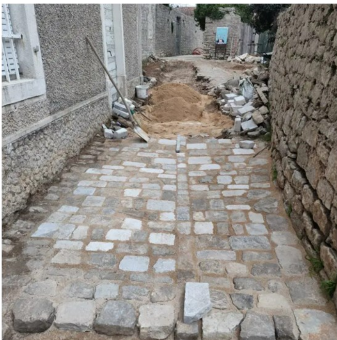
Cantieri a Ossero: pavimentazione con cemento di varie sfumature di grigio (foto Novi list)
