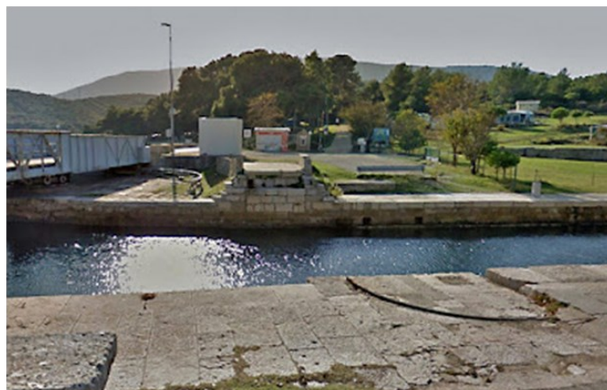
Sono rimasti a testimoniare la presenza del vecchio ponte demolito nel 1942 la sede d'appoggio e i gradini d'accesso laterali, in primo piano parte della rotaia.
