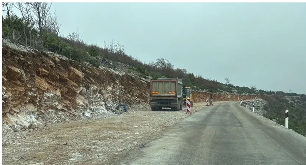
I lavori in corso sulla Cherso - Lussino (foto Novi list.hr)
