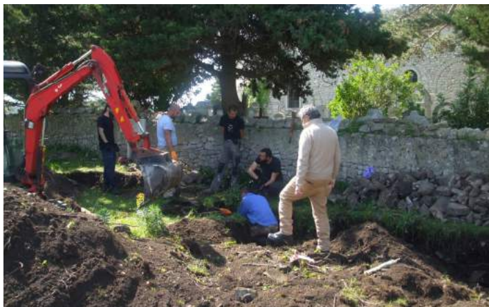
Iniziano gli scavi
